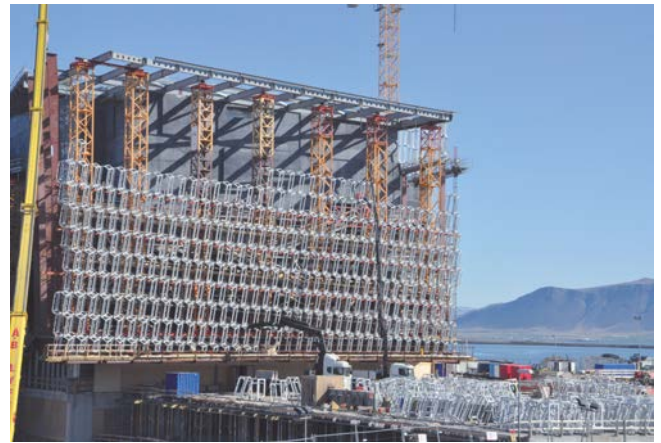
2. Изградња јужне фасаде, 2006–2007. 2. The construction of the south façade, 2006–2007.
