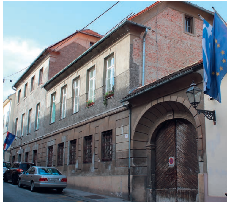
6. Zagreb, Oršić Palace (14 Opatička Street), street facade today 6. Загреб, палата Оршић (Опатичка 14), данашња улична фасада
